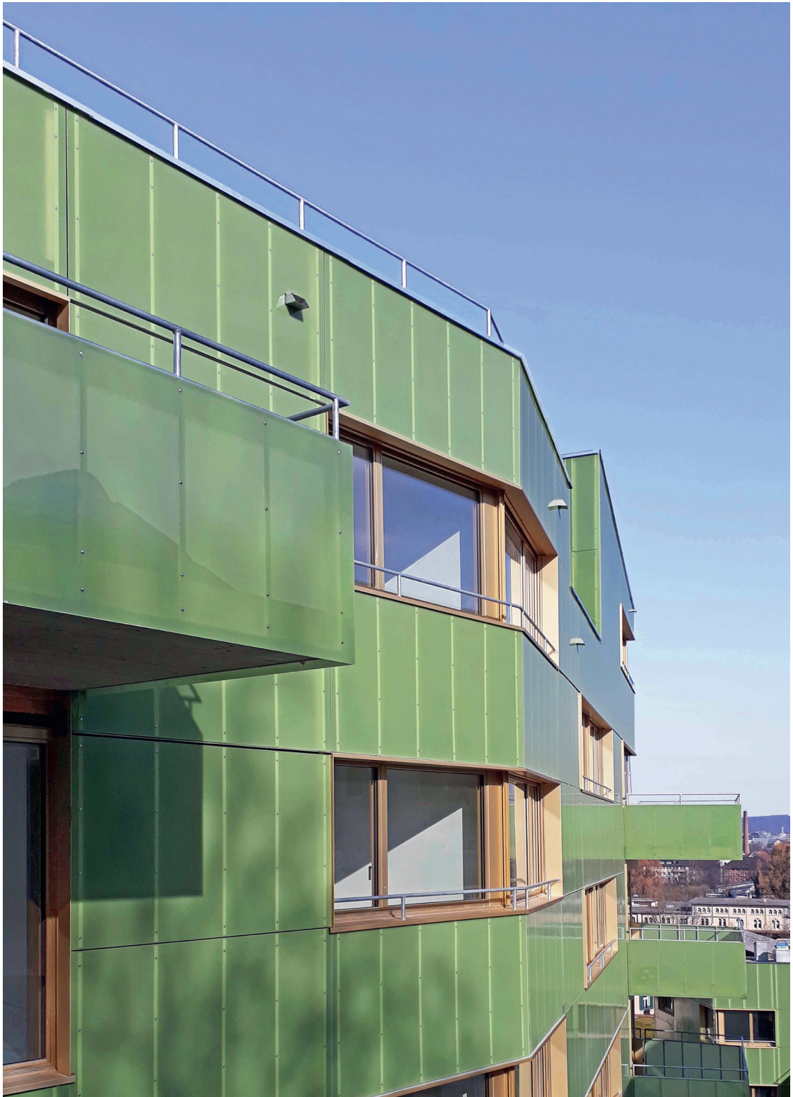
Ersatzneubau Büelrain, Winterthur
