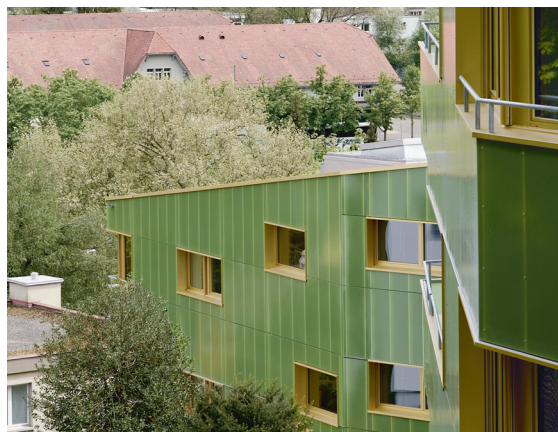
Winterthur, Büelrain-/Gutstrasse: 2018 erstellte die Habitat 8000 hier zwei Mehrfamilienhäuser mit 23 Wohnungen.
