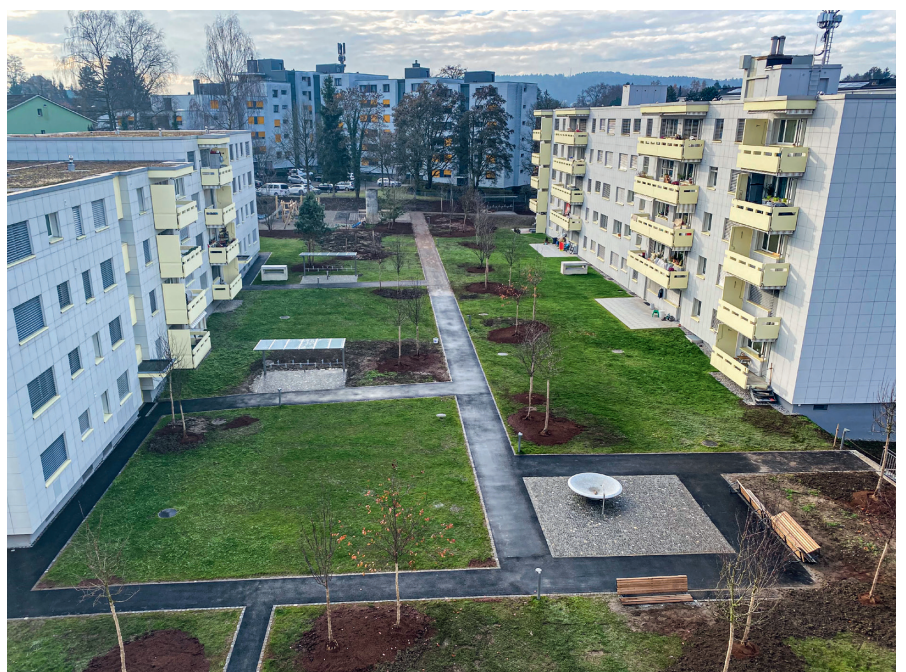
In der Siedlung Birchstrasse, Zürich, wurde die komplette Umgebung saniert.
