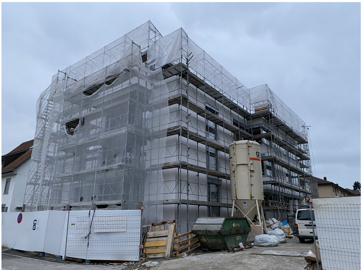
Baustelle Sandacker im Dezember 2022
