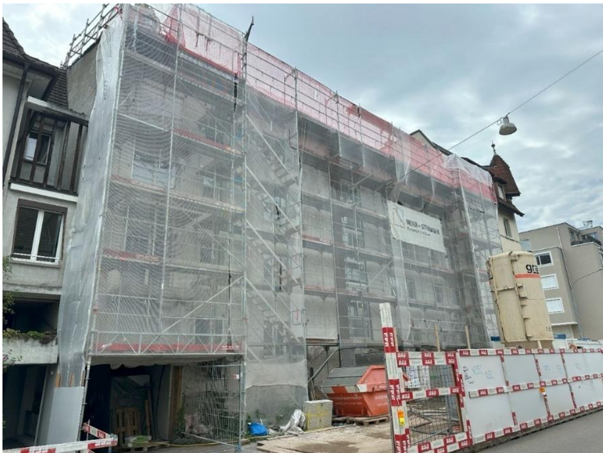
Blick auf die Baustelle im August 2025
